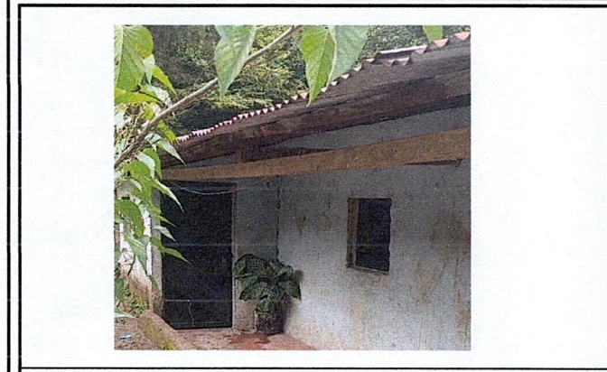
Foto 1: finalización mantenimiento de ventanas para la escuela.
