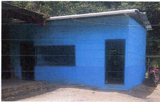
Foto 3: culminación del mejoramiento tipo pórtico.
