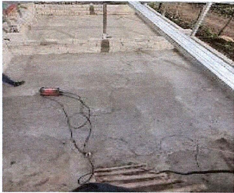
Foto 1: finalización de colocación de losa de piso torta del mejoramiento tipo pórtico.
